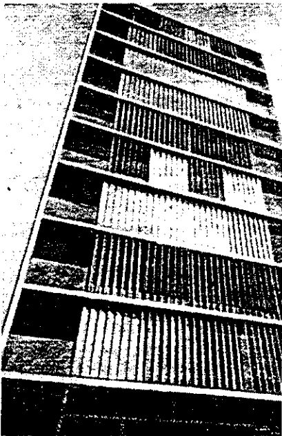
Hình 2.272. Giải pháp xử lý đầu hồi nhà bằng các tấm Panel phủ cát hạt thô ở Braitona.
