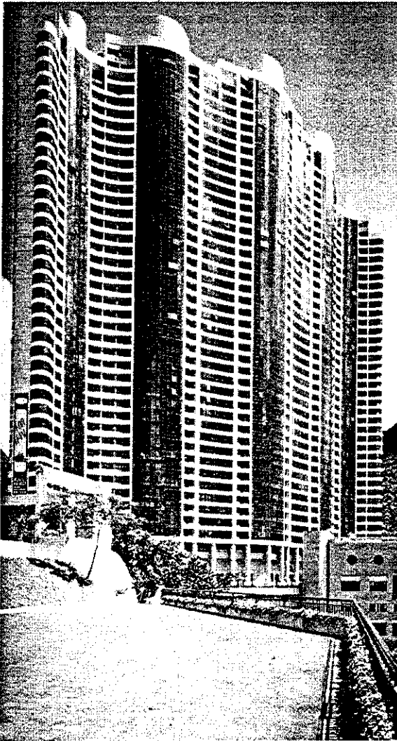
Hình 2.225. Chung cư Pacific View, Hồng Kông, Trung Quốc. Nhà cao 135m, 39 tầng, xây dựng năm 1991 - là nhà ở kiểu đơn nguyên có hình dáng mặt bằng tự do, mềm mại - tạo cho khu ở có không gian sinh động. Phôi cảnh chi tiết mặt đứng và mặt bằng tầng điển hình.
