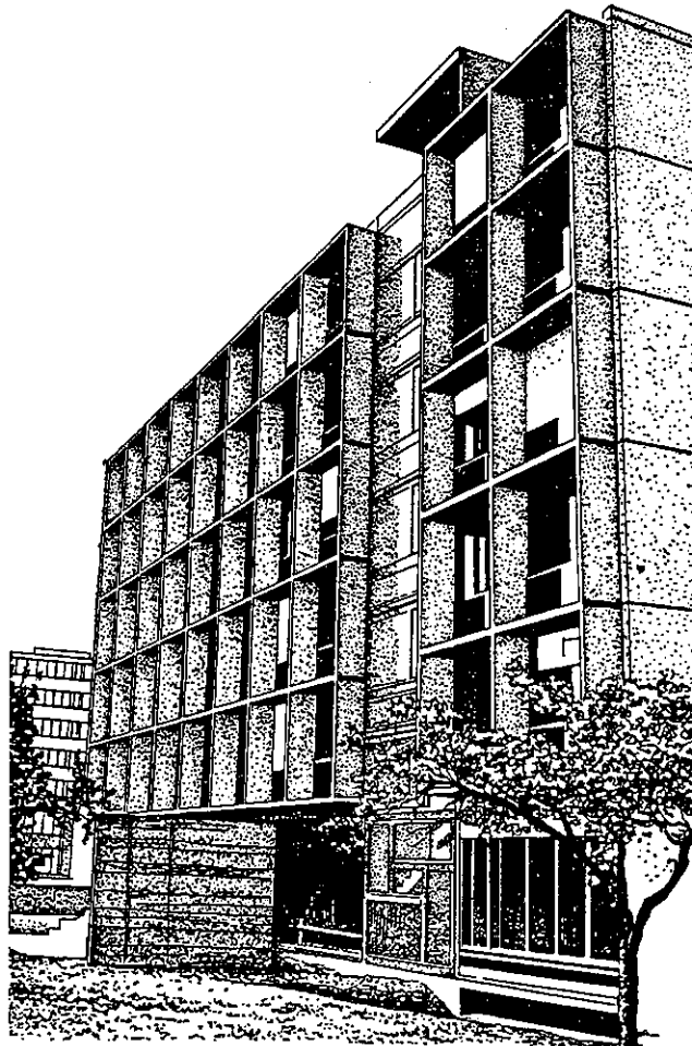
Hình 2.271. Hệ thống các tấm che nắng đứng và ngang ở khách sạn du lịch ở Geneva. Thuyết Kiến trúc. Các KTS. Lozozon, Mozer. Koeslen. 1964.
