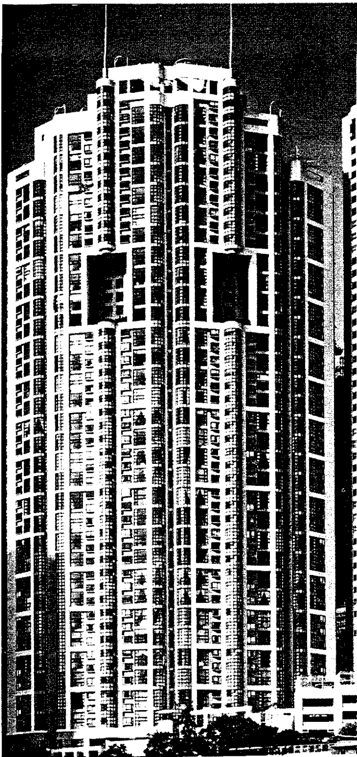
Hình 2.226. Chung cư mang tên Vườn của Nữ Hoàng. Hồng Kông, Trung Quốc. Nhà cao 167m, 35 tầng, xây dựng năm 1991 do Công ty P&T thiết kế. Đây là loại nhà ở kiểu đơn nguyên, trên mỗi tầng, mỗi đơn nguyên có 2 căn hộ bố trí vượt tầng cho nên thông gió, chiếu sáng rất tốt. Phối cảnh và mặt bằng tầng điển hình công trình.
