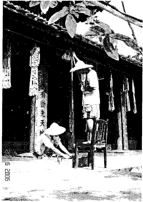
Hình 2.27c. Nhóm công tác dùng kết hợp dây dọi, nivo, đảm bảo chính xác cho đo cao từ dạ tàu xuống đường ngang chuẩn được đánh dấu ở bậc thềm
