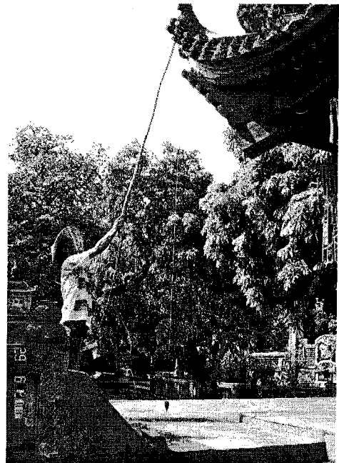
Hình 2.28b. Thực hiện xác định đầu đao xuống nền bằng dây dọi
