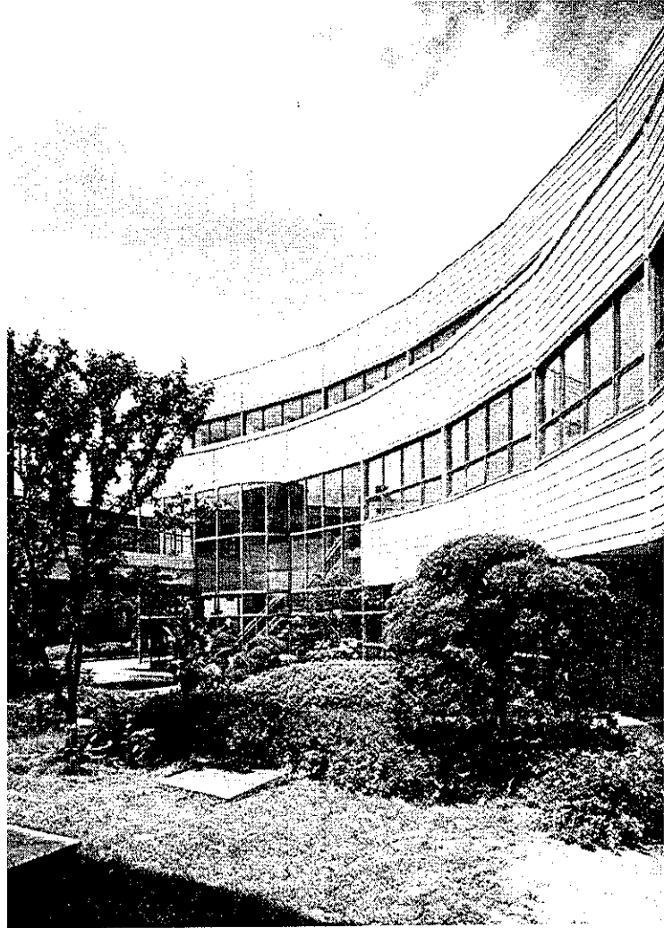
a) Cây xanh tiểu cảnh trong khu hành chính công cộng nhà máy A - San Shinwa - Hàn Quốc
