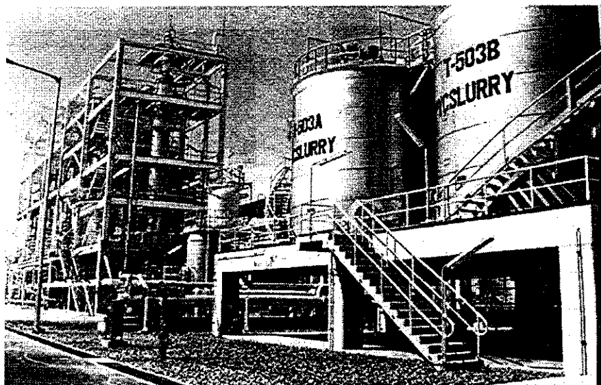
c) Bồn chứa hình trụ (Nhà máy Gaz hóa lỏng Dinh cố Bà Rịa - Vũng Tàu)
