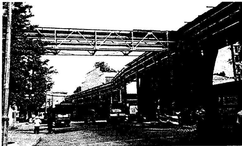
a) Cầu cạn đỡ đường ống kỹ thuật khung thép
