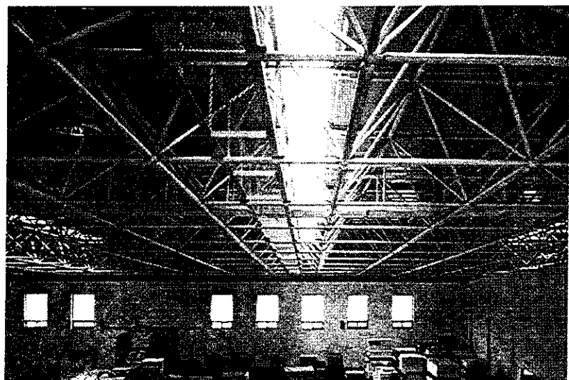
Hình 5.3. Nội thất nhà công nghiệp sử dụng kết cấu hiện đại
