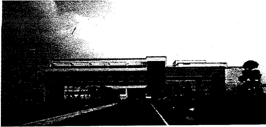
Nhà công nghiệp hai tầng của Hàn Quốc
