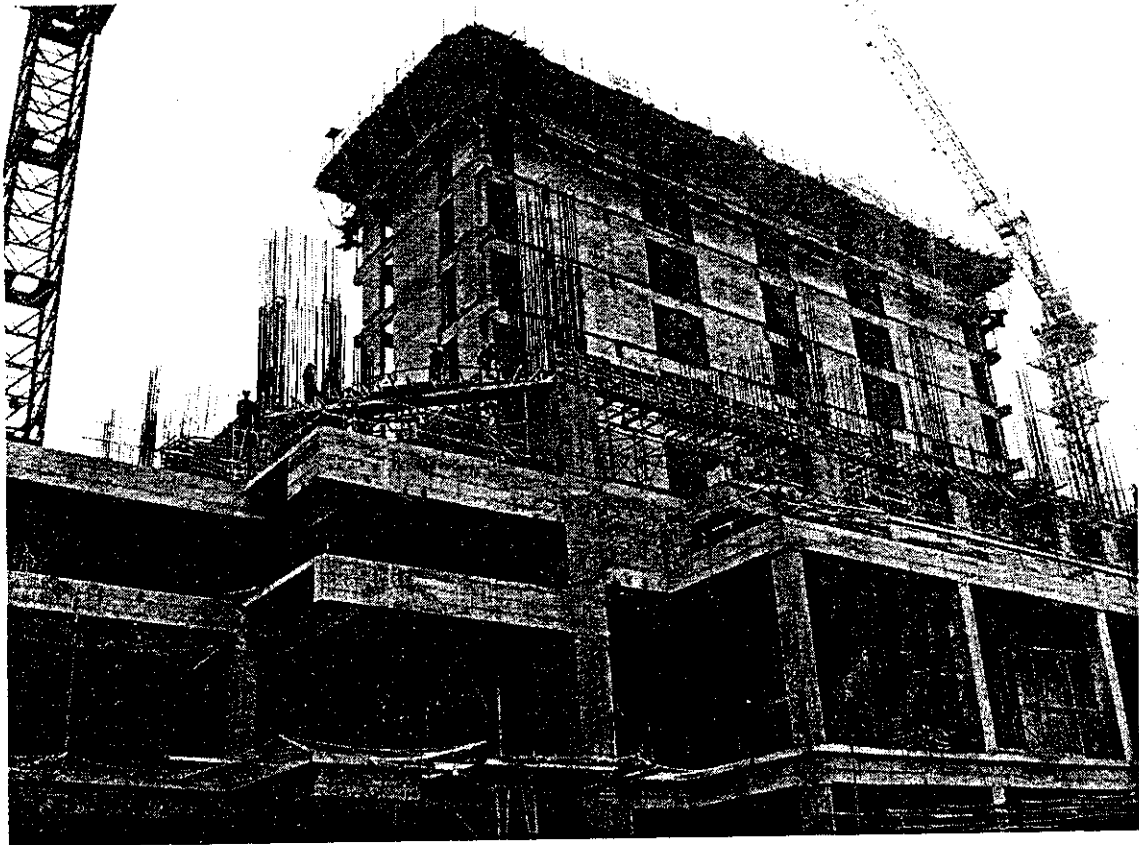
Hình 7.8. Công trình thi công bằng phương pháp trượt lõi, cột và dầm đổ toàn khối, sàn lắp ghép (Công trình Nhà 34 tầng Trung Hoà - Nhân Chính)
