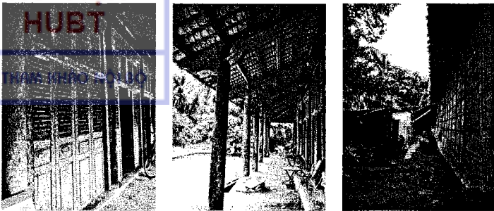
Hình 2.32. Cửa chớp mở hết mặt nhà, hiên rộng, cao, vách sau mặt ngoài ốp gỗ trong xây vách tường
