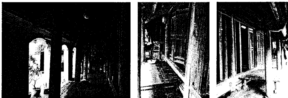
Hình 2.9. Hàng hiên trước nhà (nhà ông Nhã, thôn Đông Long, Hưng yên)
