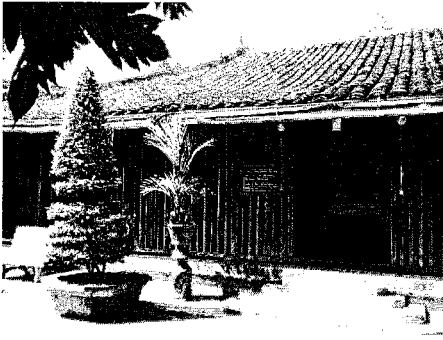
Hình 2.35. Lam gỗ chạy suốt mặt tiền nhà tạo thông thoáng và lấy sáng
