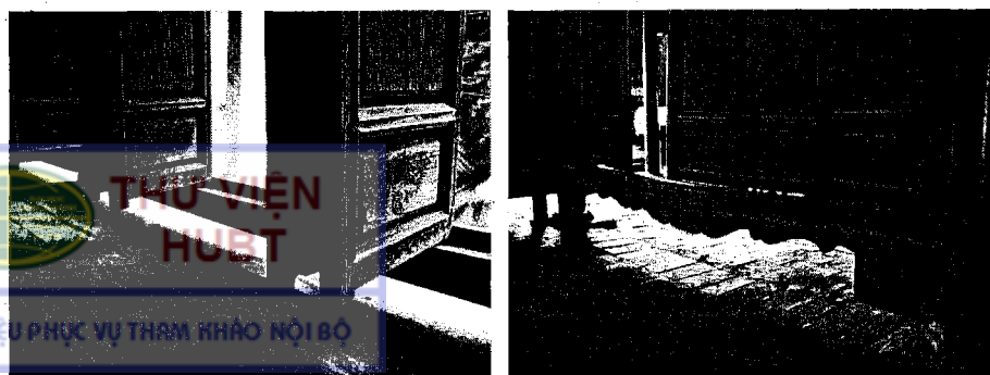
Hình 2.27. Khoảng hở giữa sàn và ngạch cửa mặt trước và vách ngăn hai bên trái nhà (nhà ông Hồ Văn Tê, Phước Tích - Huế)
