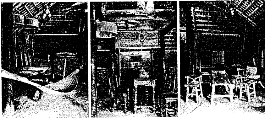
Hình 2.48. Bố trí đồ đạc nội thất, cột gỗ xoan, vách tre trát đất, sàn đất nện
