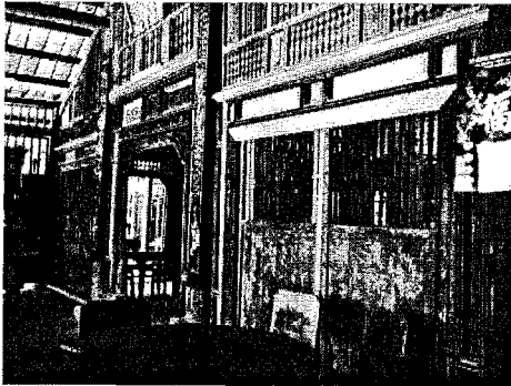
Hình 2.36. Các vách ngăn bên trong, đầu mái, nhà sau trang trí hoa văn chạm lõng hình kỷ hà, kết hợp lấy sáng, tạo thông thoáng
