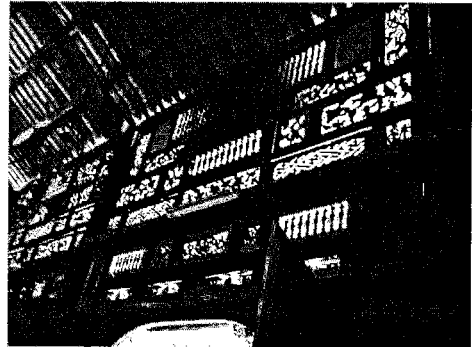
Hình 2.36. Các vách ngăn bên trong, đầu mái, nhà sau trang trí hoa văn chạm lõng hình kỷ hà, kết hợp lấy sáng, tạo thông thoáng
